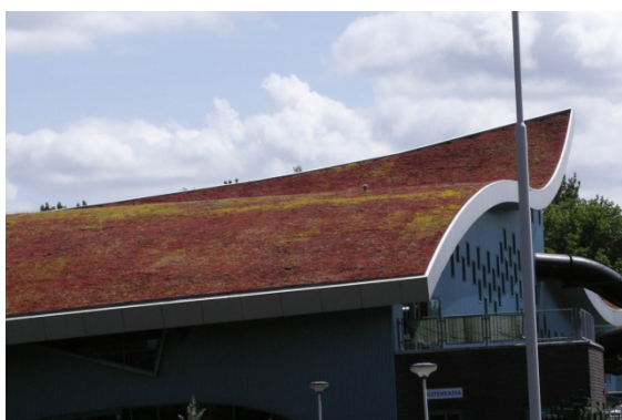
Figuur 9: Dak voorzien van een laag sedum.
