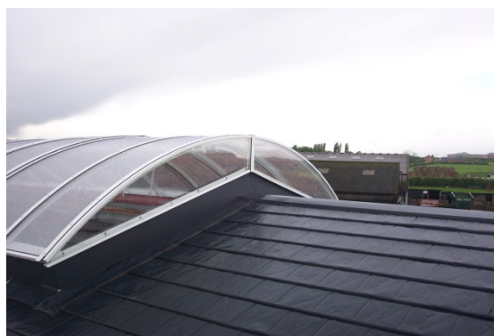
Figuur 11: Een goed isolerende daglichtstraat van polycarbonaat.
